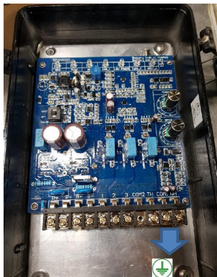
Figura9. Ubicación de puesta a tierra.
